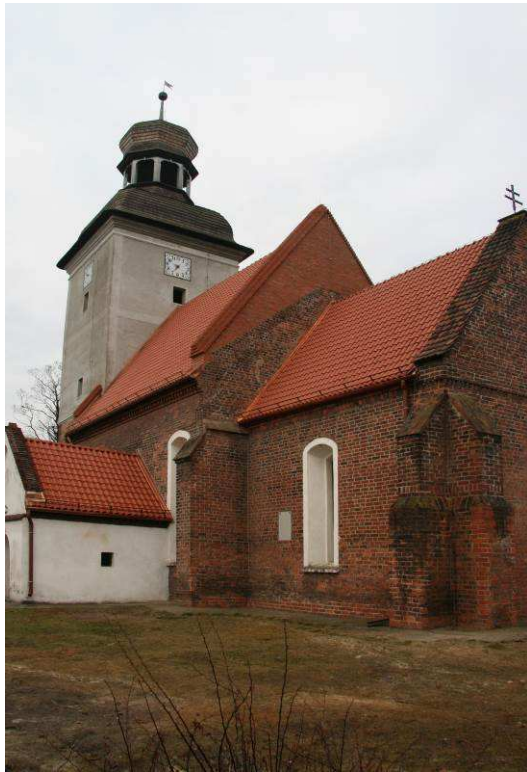
Odnowiony dach Kościoła w Strzelnikach po gradobiciu.
