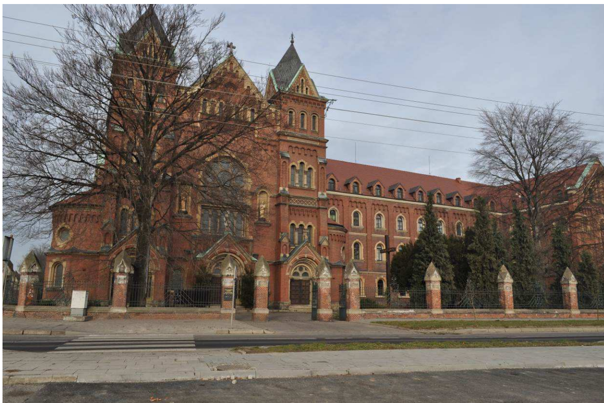
Neogotycki Klasztor Franciszkanów w Nysie po remoncie pokrycia dachowego ze środków MKiDN oraz SWO.
