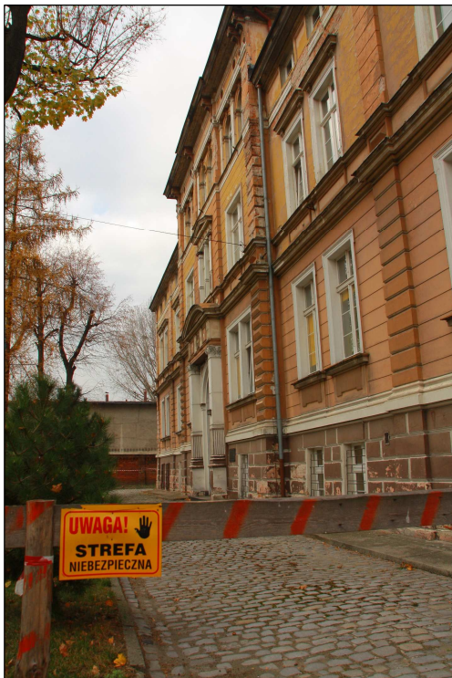
Na ilustracjach widoczne zniszczenia elewacji i zawilgocony cokół budynku
