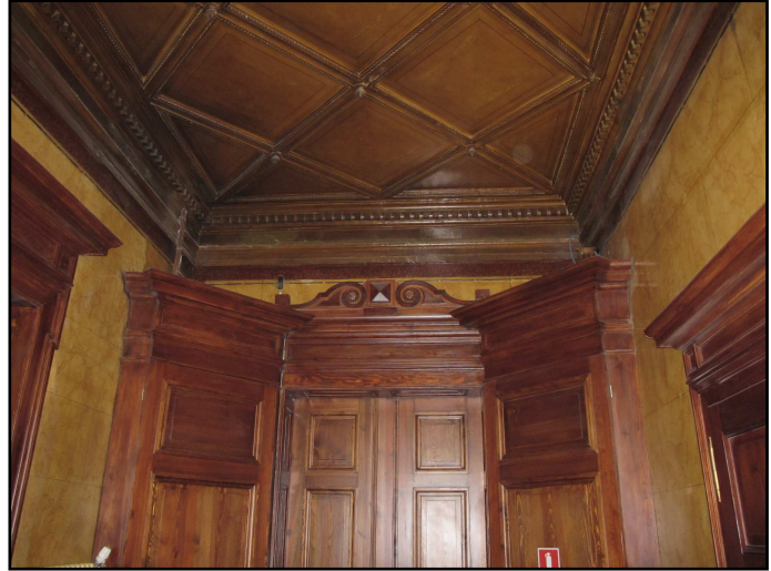
Stolarka drzwiowa po konserwacji
