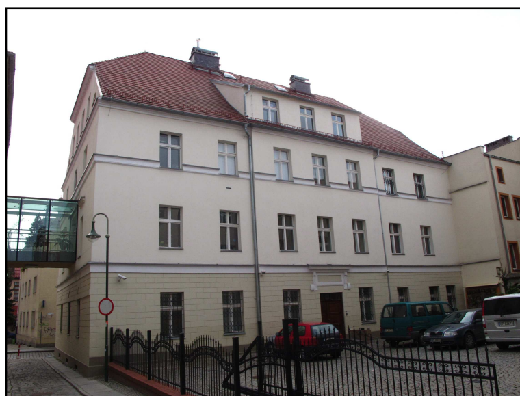
Kamienica, widok od podwórza
