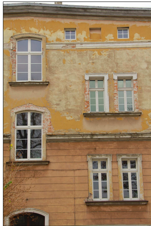
Na ilustracjach widoczne zniszczenia elewacji i zawilgocony cokół budynku
