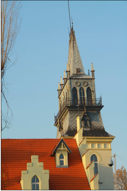
Fragment wyremontowanego dachu z wieżyczką
