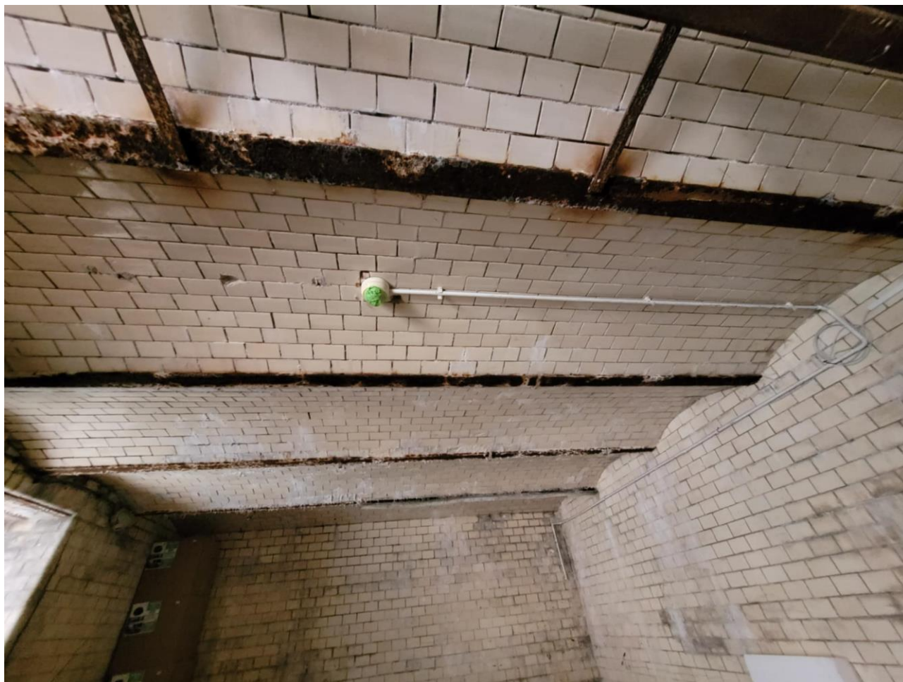
Widok na istniejące okładziny
