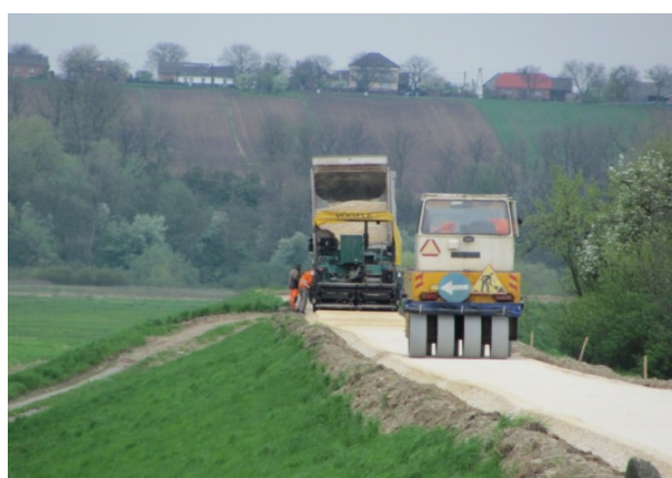
Ilustracja 39: Prace zmechanizowane – wbudowanie podbudowy i nawierzchni.
