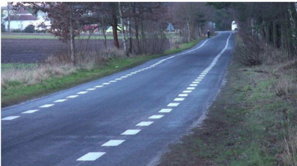
Ilustracja 41: Projekt pilotażowy: Odcinek drogi powiatowej nr 2628G o łącznej długości 5,3 km, pomiędzy m. Chojniczki a skrzyżowaniem z drogą wojewódzką nr 235.
