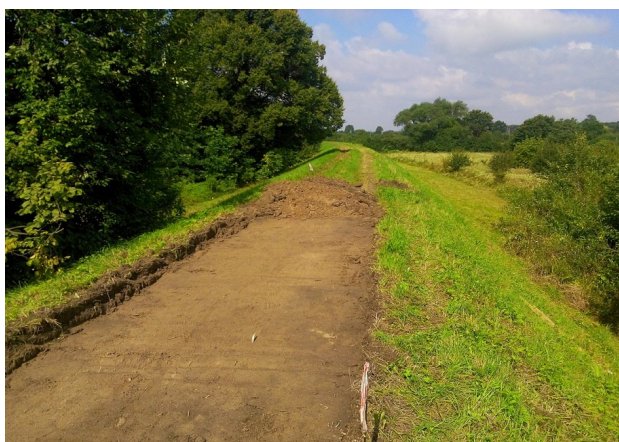
Ilustracja 38: Wykonanie korytowania na koronie wału przeciwpowodziowego.
