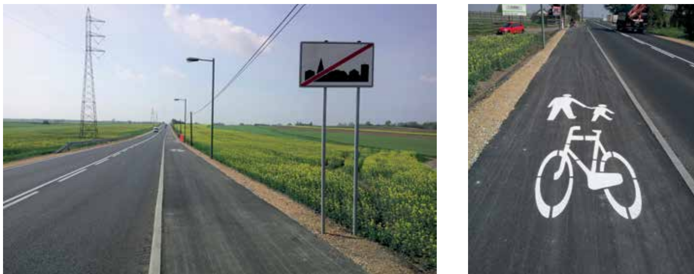
Fot. 1. Ciąg pieszo-rowerowy przy DW 901 w Oleśnie
