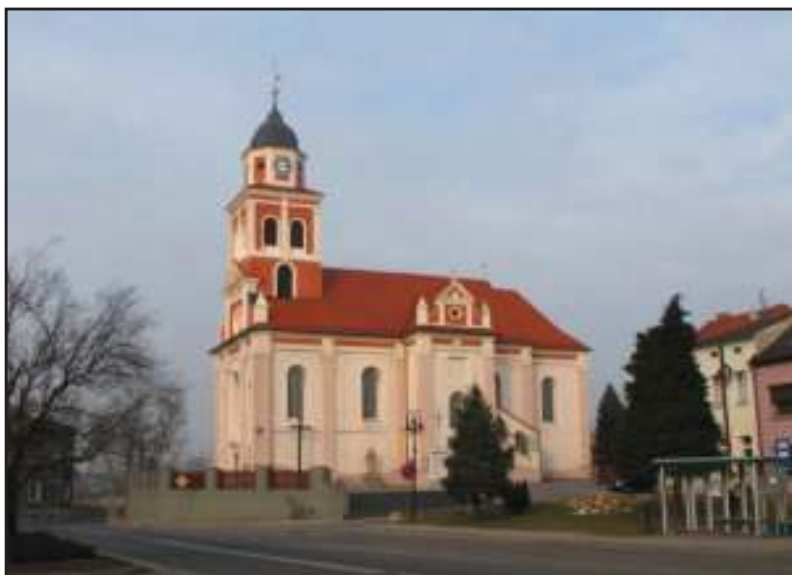
Fot. 11. Kościół parafialny pw. św. Jerzego w Prószkowie
