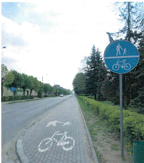
Fot. 2. Ciąg pieszo-rowerowy przy DW 901 w m. Zawadzkie
