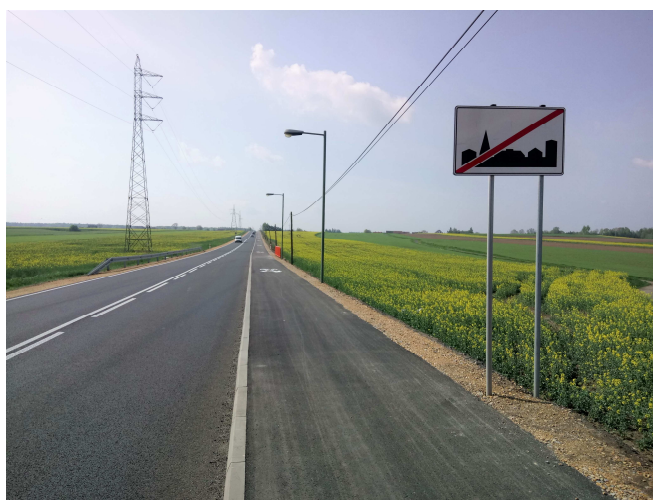
Fot. 1. Ciąg pieszo-rowerowy przy DW 901 w Oleśnie
