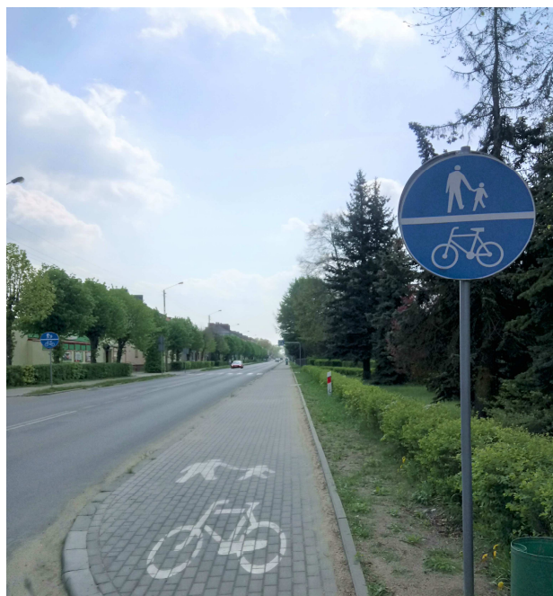
Fot. 4. Ciąg pieszo-rowerowy przy DW 901 w m. Zawadzkie
