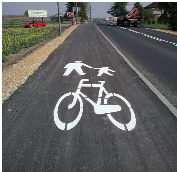
Fot. 2. Ciąg pieszo-rowerowy przy DW 901 w Oleśnie
