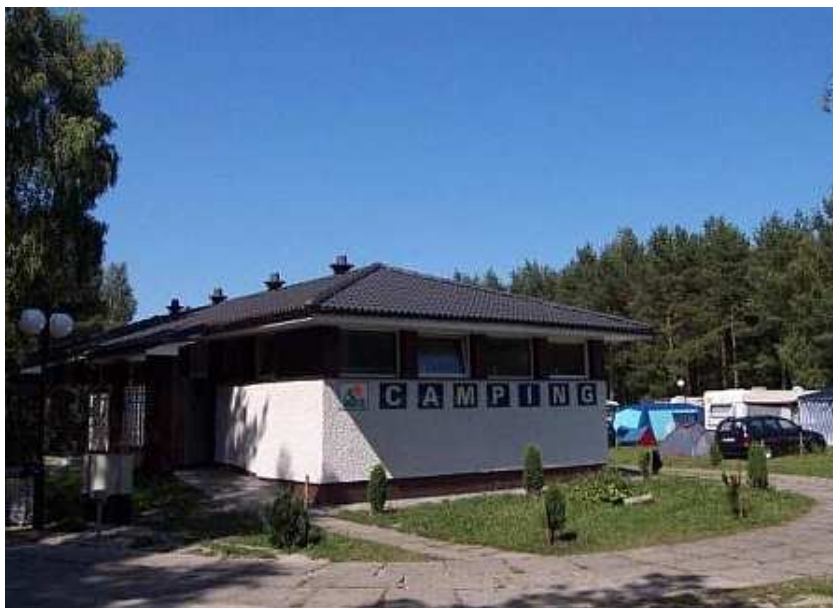
Pawilon sanitarny na campingu [camping nr 21 „Morski” w Łebie]
