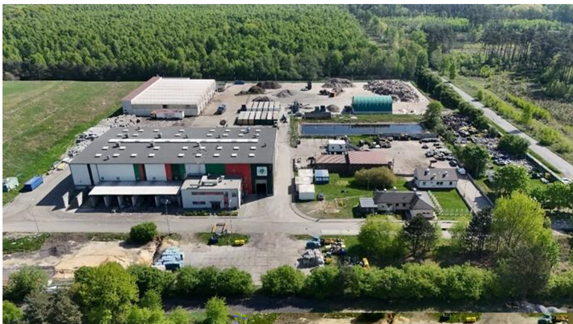
Rysunek 69. Widok na instalację MBP zlokalizowaną w Kędzierzynie-Koźlu 151
