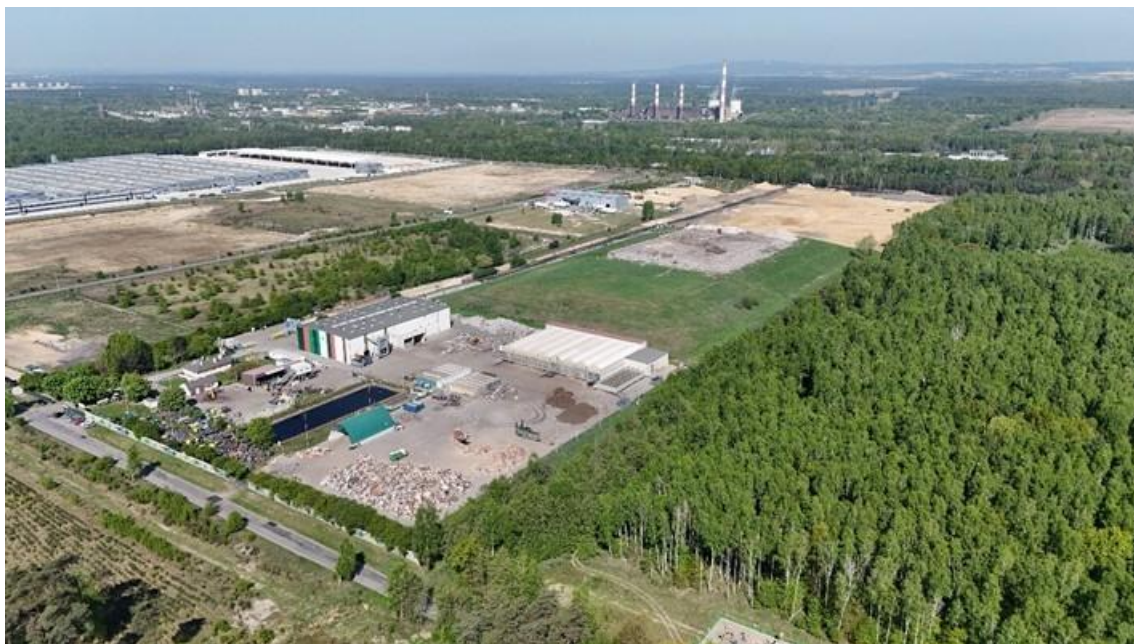
Rysunek 70. Widok na instalację MBP zlokalizowaną w Kędzierzynie-Koźlu 152
