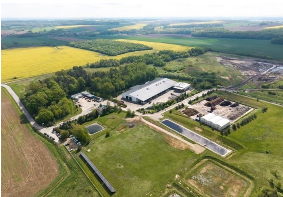
Rysunek 67. Widok na instalację MBP zlokalizowaną w Domaszkowicach gm. Nysa 149
