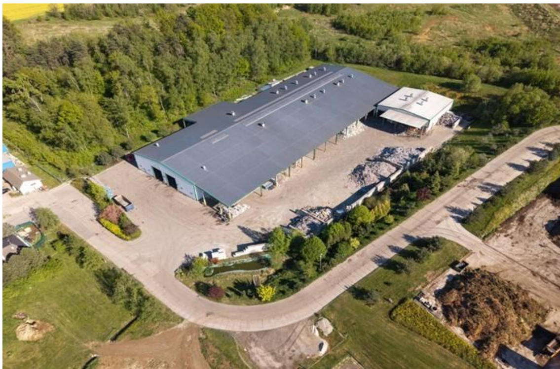
Rysunek 68. Widok na instalację MBP zlokalizowaną w Domaszkowicach gm. Nysa 150
