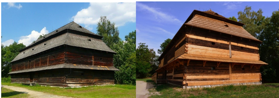
Ryc. 4 Muzeum Wsi Opolskiej w Opolu. Spichlerz dworski ze Sławięcice przed i po pracach remontowych, fot. ze zbiorów MWO w Opolu
