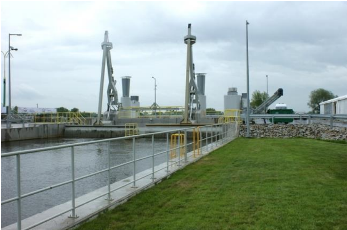
Rysunek 11. Elektrownia Wodna Dobrzeń (Źródło: https://pgeeo.pl/Nasze-objekty/Elektrownie-wodne/Dobrzeń )
