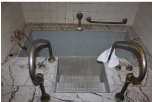
Moszna. Prace przy drzewostanie parkowym - aleja lipowa (fot. I. Solisz), Konservacja i renowacja łazienki w Apartamencie Białym, dofinansowanie OWKZ (1 stan przed pracami, fot. I. Solisz, 2 stan po konserwacji - fot. T. Wilk).
