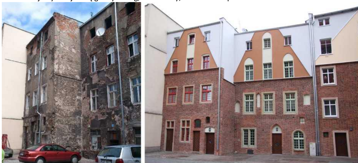
Wyremontowane kamienice w Brzegu przy ul. Dzierżonia 8 i 10 - dotacja Gminy Brzeg (1) stan przed rozpoczęciem prac, fot. I. Solisz, (2) odbiór prac w 2016 r., fot. P. Godlewski.
