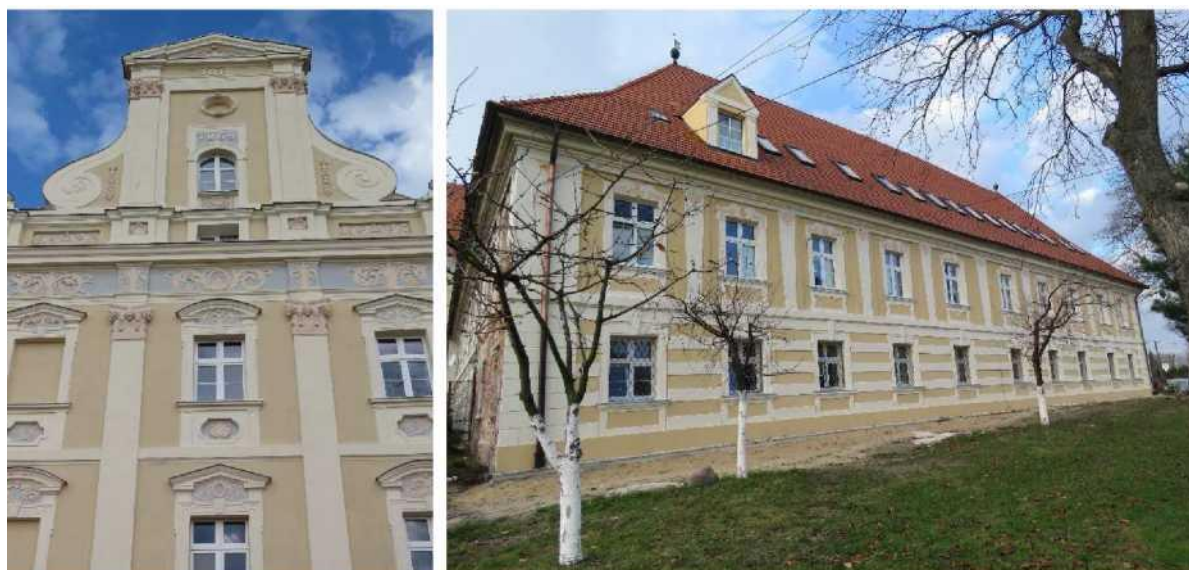
Czarnowąsy, dawny Klasztor Norbertanek: remont konserwatorsko-budowlany z wystrojem architektoniczno-rzeźbiarskim elewacji południowej Domu Zakonnicy (szczytu) w 2016 r. i Prałatury - elewacja wschodnia 2017 r., (fot. I. Solisz). Dotacja udzielona przez MKiDN oraz przez SWO i OWKZ.
