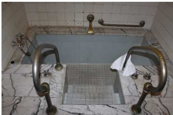
Moszna. Prace przy drzewostanie parkowym – aleja lipowa (fot. I. Solisz), Konservacja i renowacja łazienki w Apartamencie Białym, dofinansowanie OWKZ (1 stan przed pracami, fot. I. Solisz, 2 stan po konserwacji – fot. T. Wilk).
