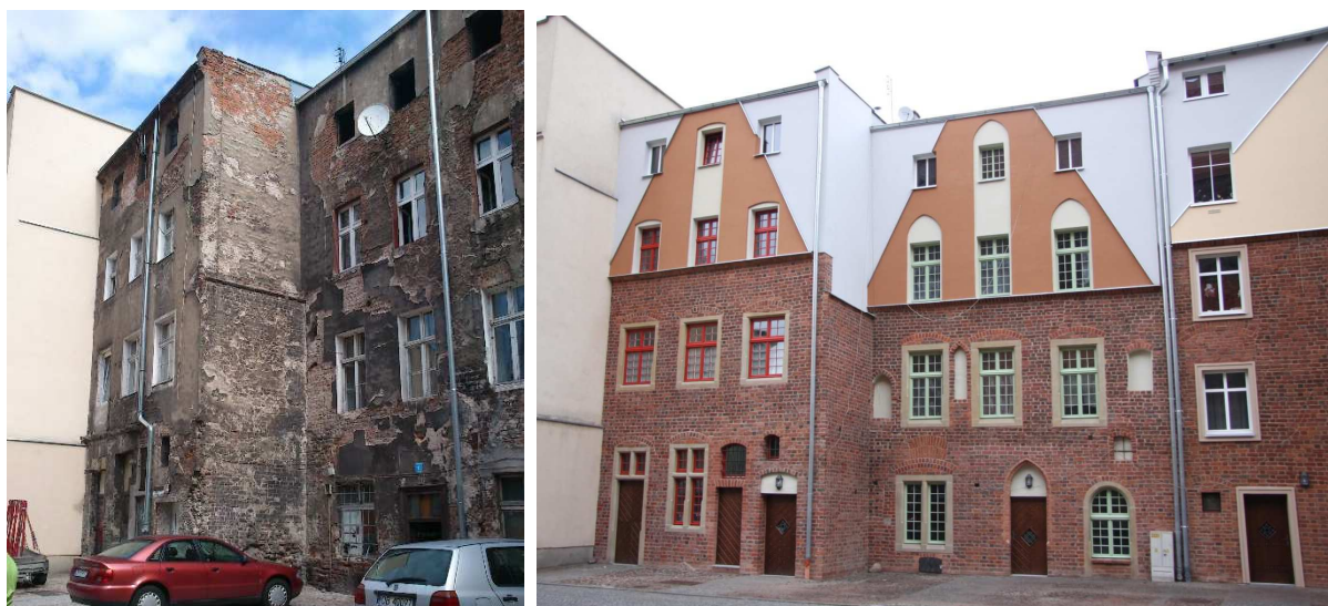
Wyremontowane kamienice w Brzegu przy ul. Dzierżonia 8 i 10 – dotacja Gminy Brzeg (1) stan przed rozpoczęciem prac, fot. I. Solisz, (2) odbiór prac w 2016 r., fot. P. Godlewski.
