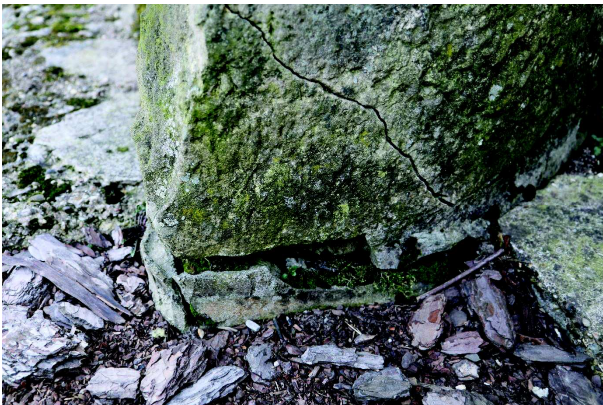
Fot.7. Pęknięcia podstawy kamiennej rzeźby nimfy, w miejscu wykroczenia kamienia poza granicę fundamentu.
