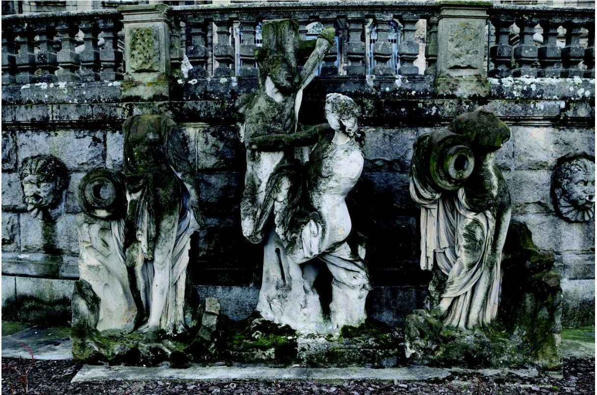
Fot.1. Grupa rzeźbiarska Diabeł (satyr) z nimfami. Stan zachowania. Widoczne rozległe ubytki formy rzeźbiarskiej, destrukcja powierzchni; nierównomierne nawarstwienia zanieczyszczeń atmosferycznych, wykwitów mikroflory.
