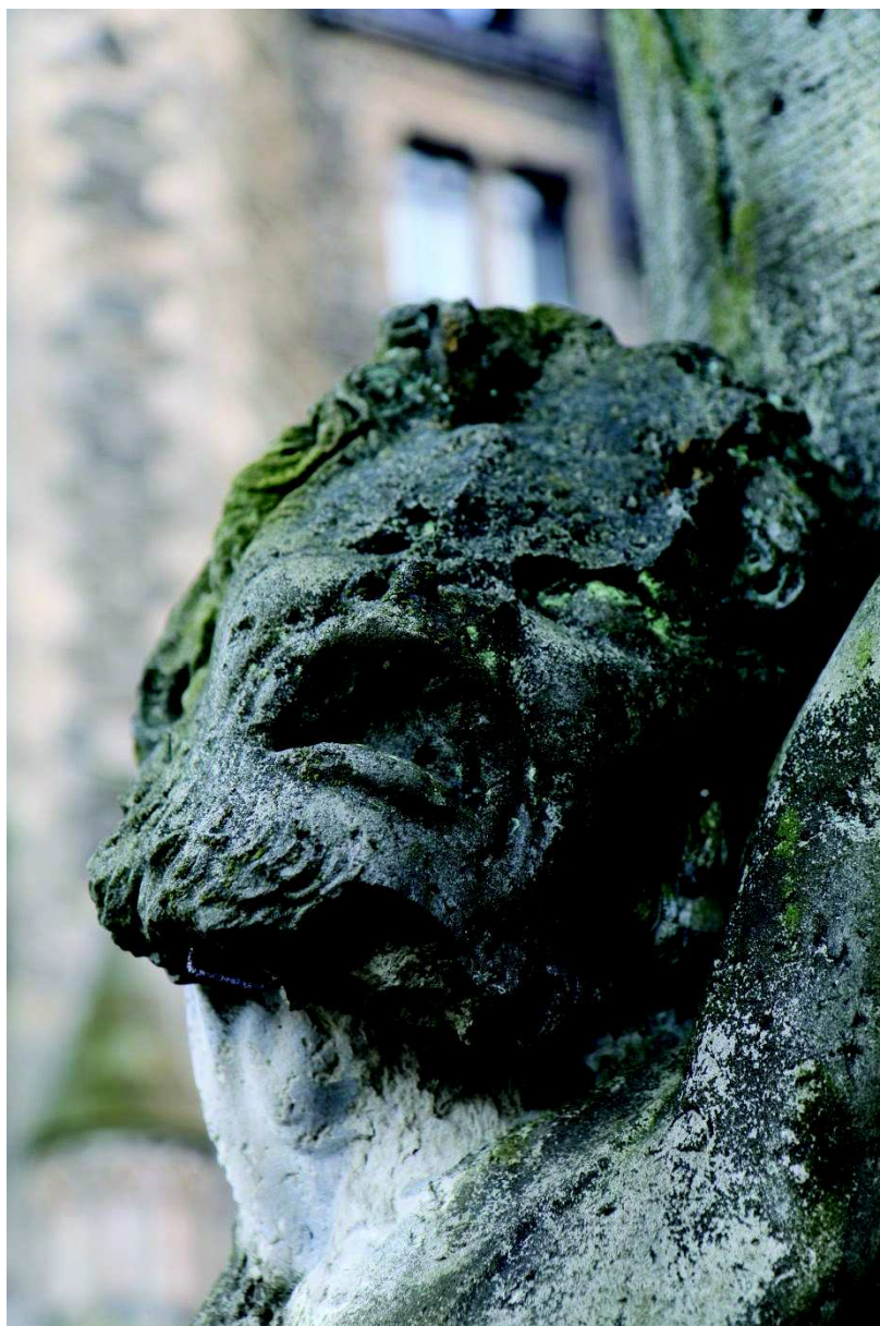
Fot.3. Stan zachowania głowy Satyra. Widoczne zniszczenia form detali anatomicznych i okaleczenie powierzchni; nawarstwienie zanieczyszczeń; korodujące zbrojenie po wtórnym uzupełnieniu (na brodzie).
