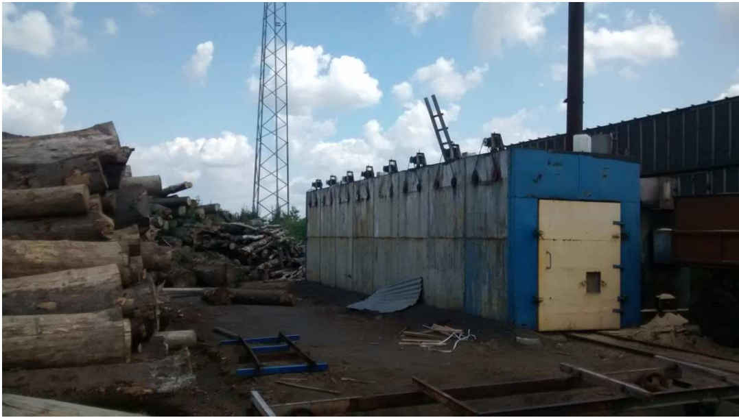
Rys. 7. Suszarnia drewna w tartaku Odelga w Prószkowie opalana zrębkami drewna
