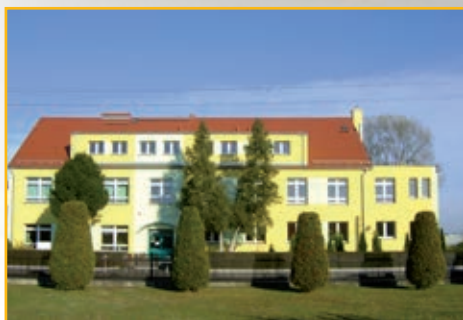
Szkoła podstawowa w Kadłubie, wyremontowana w ramach projektu RPO WO 2007-2013
