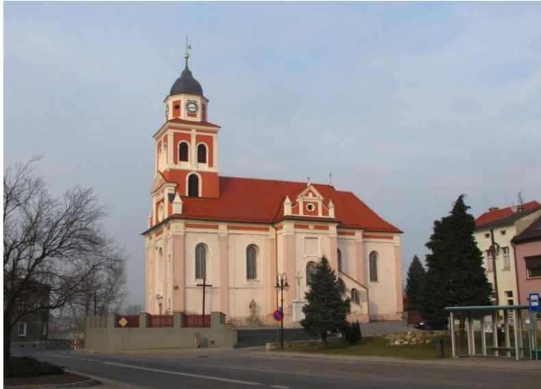
Fot. 11. Kościół parafialny pw. św. Jerzego w Prószkowie
