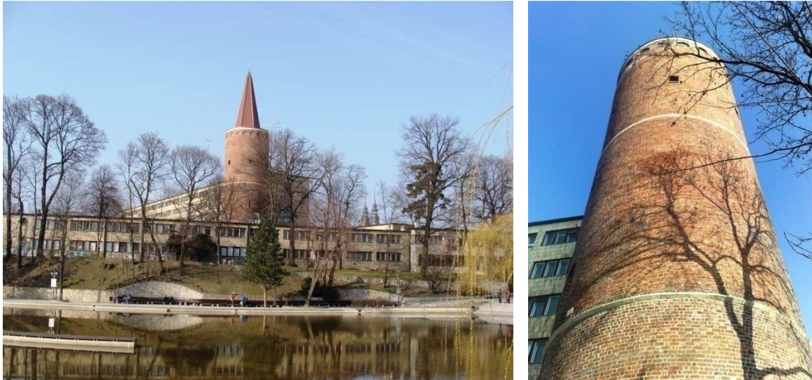
Fot. 36-37. Wieża Piastowska w Opolu po remoncie (źródło: www.nid.pl )
